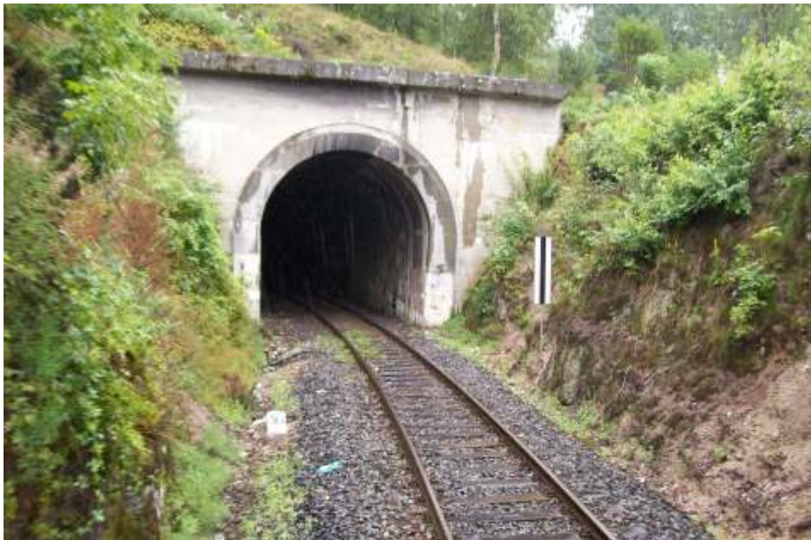
Tunnelausgang auf kurvenreicher Strecke kurz vor Nejdek
