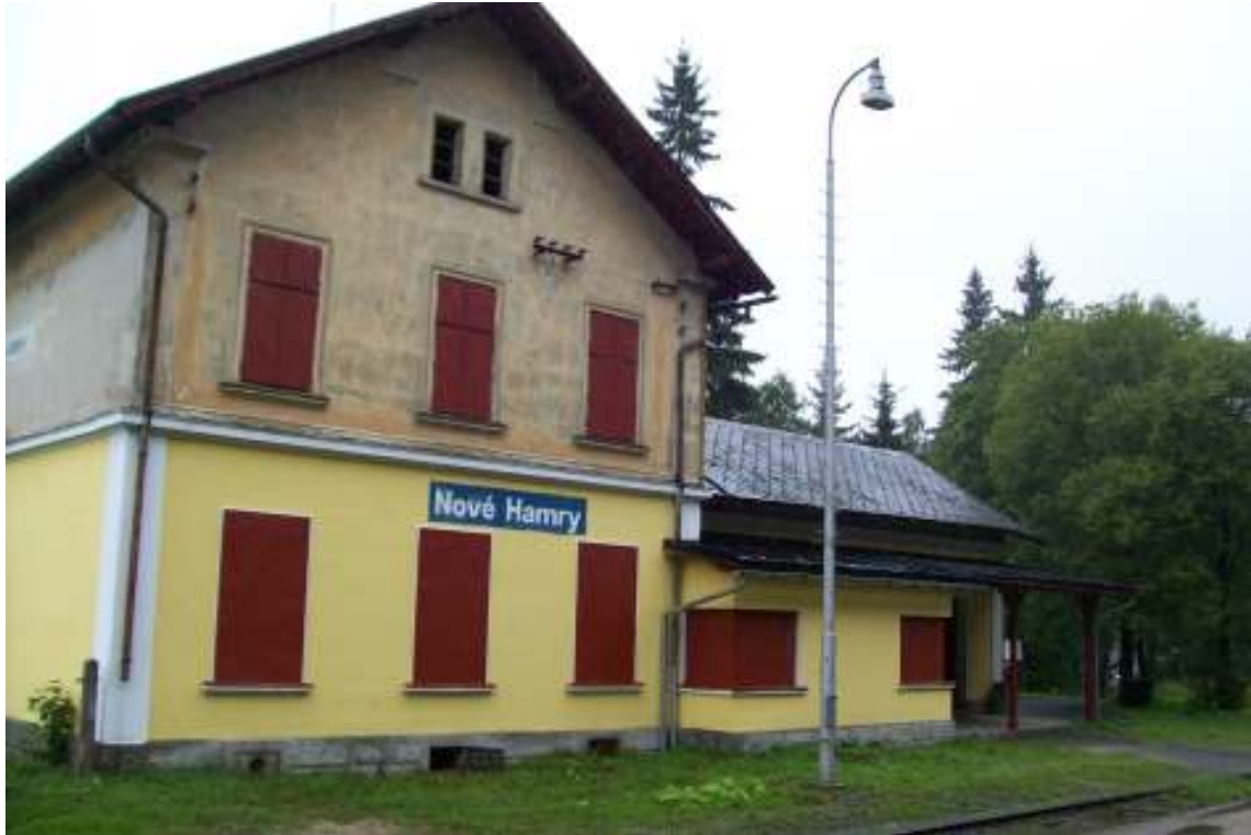
Die Maler arbeiten sich auf der Bergstrecke stationsweise von oben nach unten, hier am Haus ist es umgekehrt
